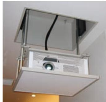
別途建築工事にて、架台・補強工事が必要です。天井化粧カバーは別途仕上げになります。
