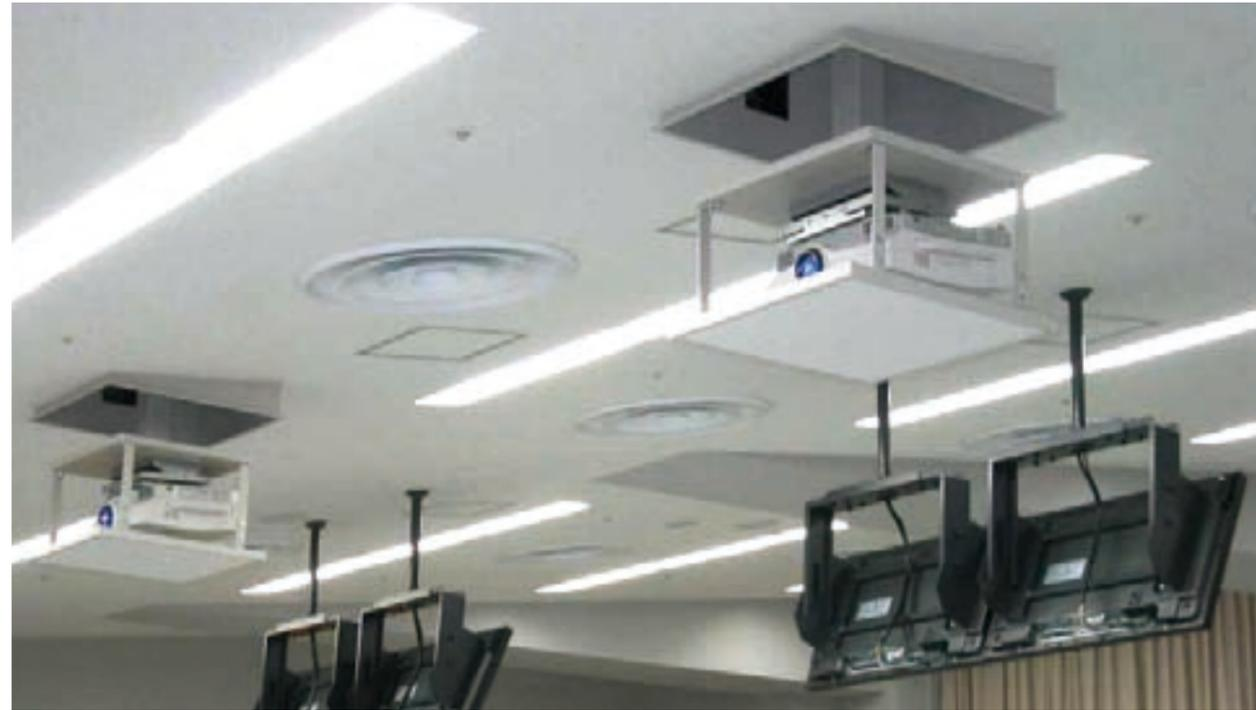
オーエススクリーンは常に、プロジェクターと一体の関係にあります。私たちの提案するプロジェクター設置の中でも、大型スクリーン+プロジェクターの組合せは、常にオリジナリティを求められます。オーエスのプロジェクター昇降機は、スクリーンとの関係を経験値から導き出し、プロジェクターの性能を最大限に引き出すよう、設置環境に合わせたオリジナル設計を致します。
