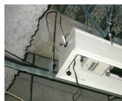
スラブから吊ボルトでALを固定
