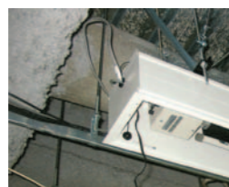
スラブから吊ボルトでALを固定
