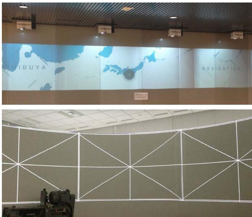
R壁に曲面補正とブレンディング処理をして横幅10mの映像を投映。普段は待機映像が流れ、来客者がゾーンに入るとリモコンでコンテンツを再生します。その際には照明も連動します。また、新商品発表などのプレゼン用途も考え、持込PC映像を映し出すことも可能です。
