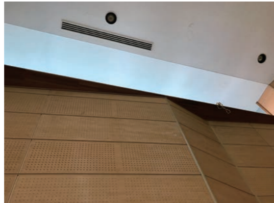
音響調整板 (有孔吸音一体板) 音響調整板の裏面にはグラスウール
