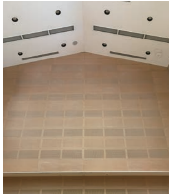
ホールの壁面一面に貼られた音響調整板
