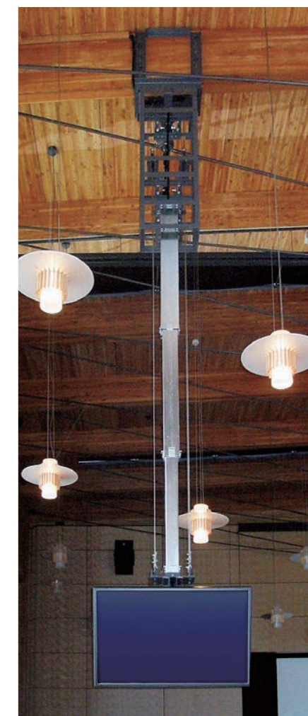
メンテナンスが楽な、高天井用のロングストローク
