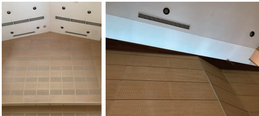
ホールの壁面一面に貼られた音響調整板
