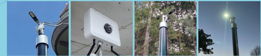
LED照明、通信機器 お天気カメラ LED照明、通信機器、監視カメラ LED照明、通信機器
