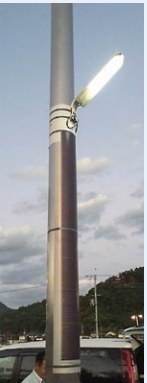
既設ポールへの設置
