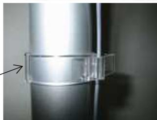
クランプホルダー を六角棒スパナ で緩めて開き、所定の高さ位置でボタンボルトを掛けた後、締め付けて下さい。
